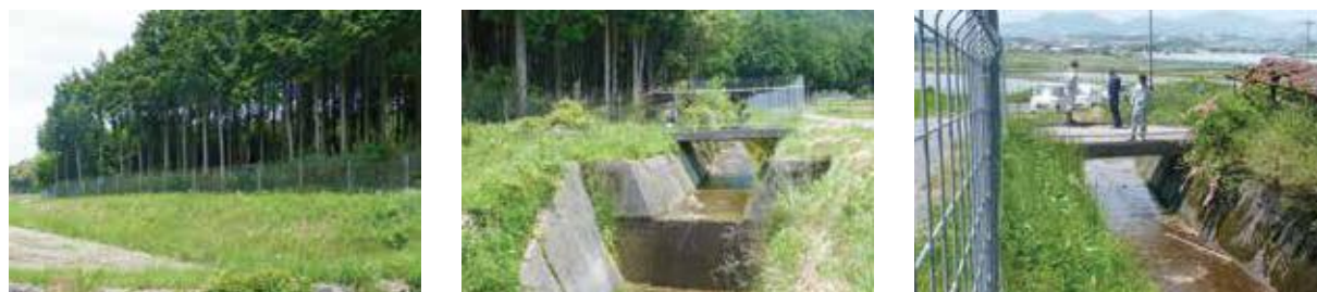
■ 山を囲み集落や耕作地への侵入を防止しています。 ■ 河川だけしっかり侵入経路が残っています。 ■ 左の画像を獣側から撮影しています。これではとても簡単に侵入されてしまいます。
